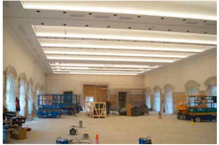
Endmontagephase der insgesamt 136 Metall-V-Akustikdeckensegel Fotos: BER Deckensysteme
